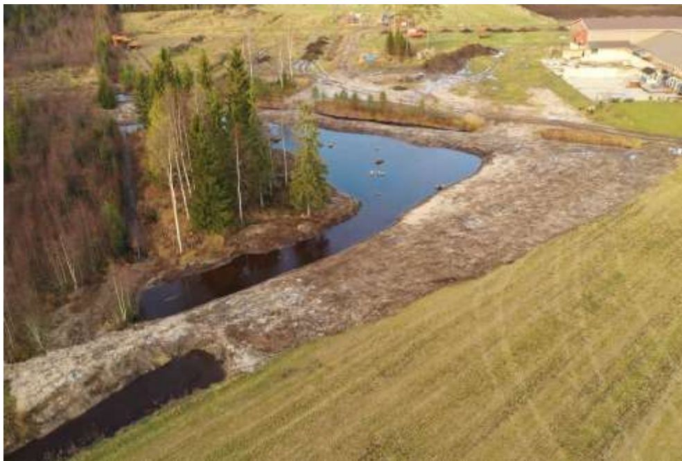
Ylivieskan Koivuniemen kosteikko rakentamisen jälkeen valmiina.
