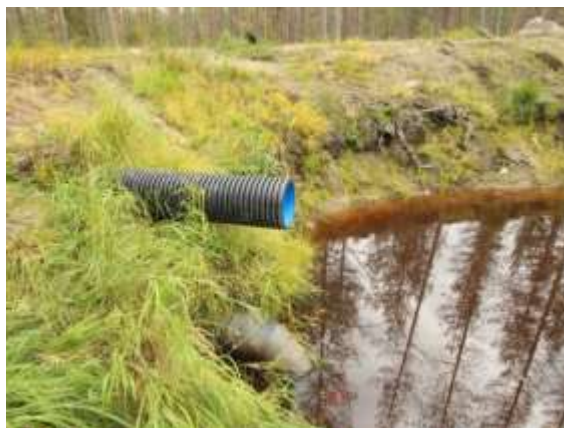
Putkipato metsätalouden vesiensuojelussa. Yläkuvassa putkipato on kuvassa olevan laskeutusaltaan oikeassa reunassa ja alakuvassa se lähikuvassa. Alemmasta putkesta virtaa vesi ns. kesävesitilanteessa ja ylempi putki on tulvaputki. Molemmat mitoitetaan valuma-alueen laajuuden perusteella. Pudasjärvi.
