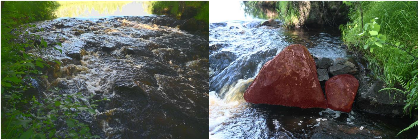
Kuvat 28 ja 29. Kuvassa 29 on kalankulkuväylältä poistettavat kivet varjostettu punaisella.
